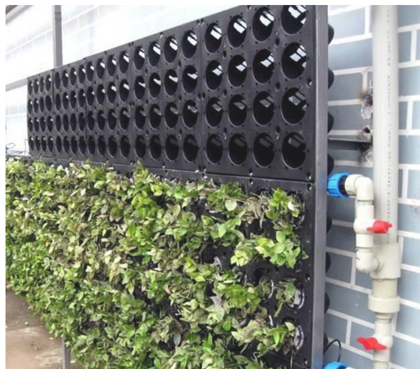
'Living wall system' in opbouw met daarnaast irrigatiesysteem.
